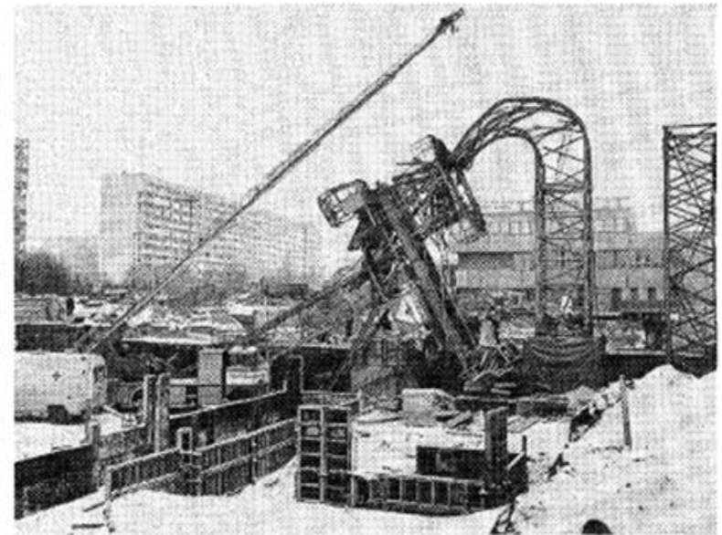
Wie Streichhölzer waren die Stahlträger und -streben des Turmdrehkrans weggeknickt. Der Ausleger lag über der Baugrube. MZ-Foto: B. Wiederhold
